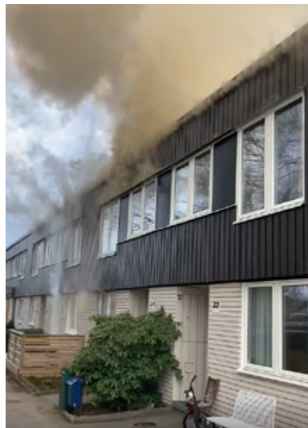
Branden spred sig via den träbäcklädda fasaden.
